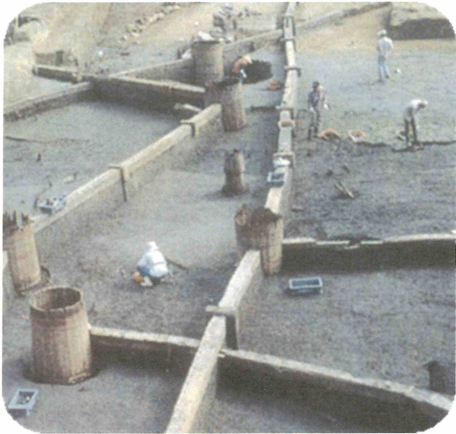
発掘された江戸の上水道
